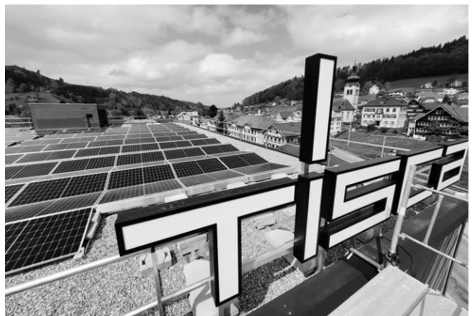
*Mit der neuen Photovoltaikanlage auf dem Tisca-Dach in Bühler werden pro Jahr etwa 150 000 kWh Energie produziert. Diese Energie reicht, um 30 Einfamilienhäuser mit Energie zu versorgen.*
